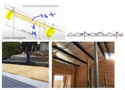
La chapa nunca se embuta dentro de la pared. Tiene por encima del muro una cupertina.
