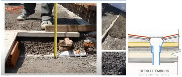
\*AISLACIÓN: Reforzamos embudo y babetas:Con material cementicio. con un entramado (malla) o con membrana en rollo (geotextil) o con aluminio.
