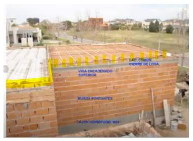
\*Cierre de losa: Con ladrillo común de canto. Para cerrar el anillo superior y que cuando se llene la capa de compresión quede contenido el hormigón.
